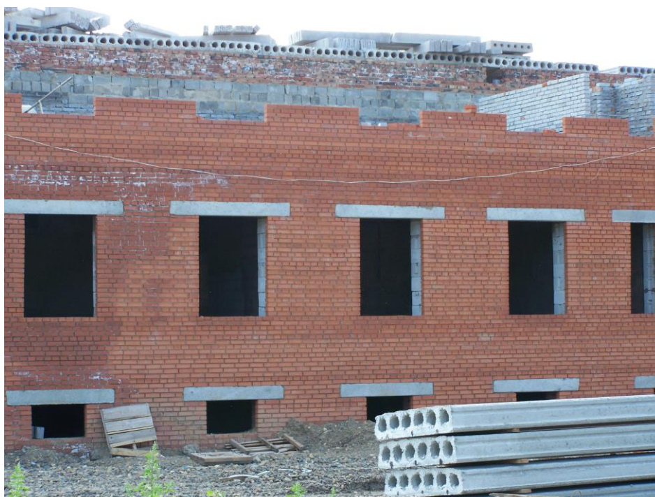
Новая библиотека в стадии строительства. 2007г.
